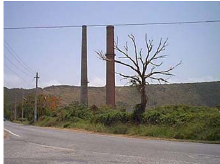
Chimeneas Históricas de la Central de Guánica
