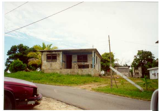
Casa en construcción
