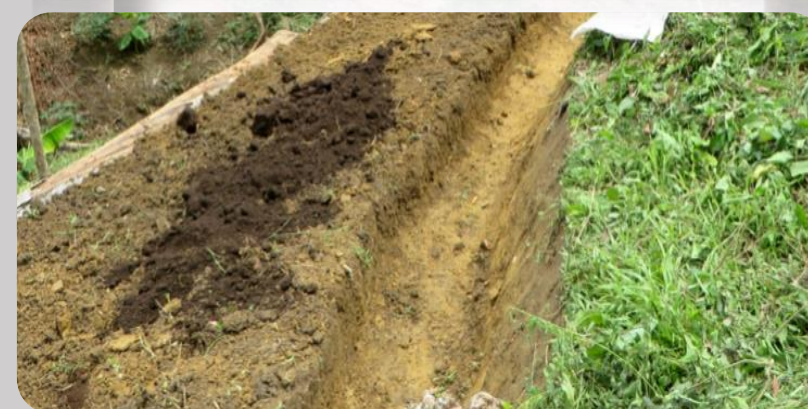
Zanja al contorno
