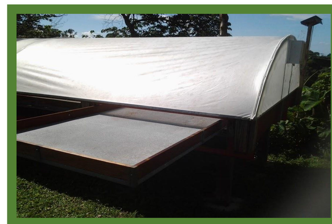
Secado al sol utilizando gavetas, las cuales se pueden guardar en el interior de la estructura cuando las condiciones climatológicas lo requieren, y en las noches.
