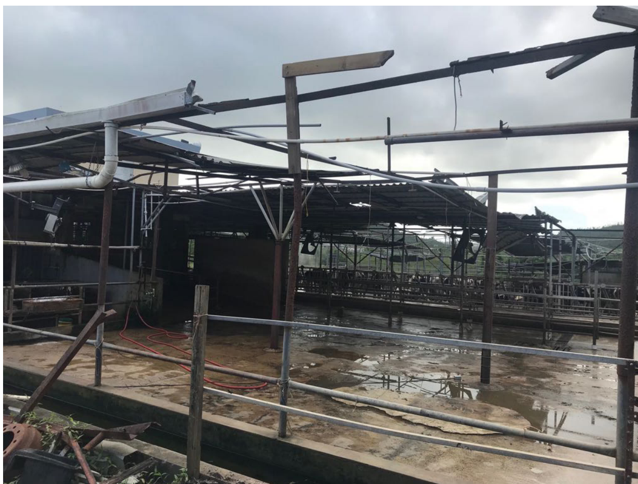
Foto 2: Techo de la sala de espera en Vaquería Victor Ayala quedó completamente destruido debido a los fuertes vientos (Bo. Collores, Humacao).
