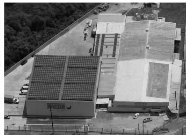
Vista aérea en la que se observan los paneles solares para la producción de electricidad.
