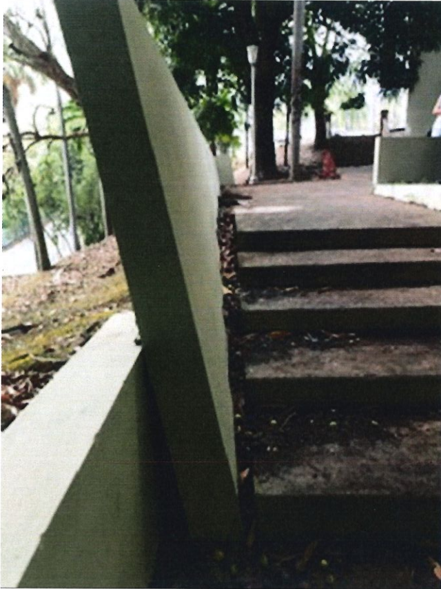
Rotación de baranda en área de la acera que conduce a la escalinata (El Calvario)
