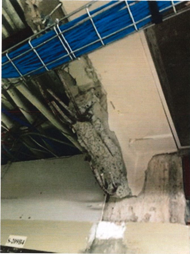
Demolición de pared de hormigón que no es continua con columna
