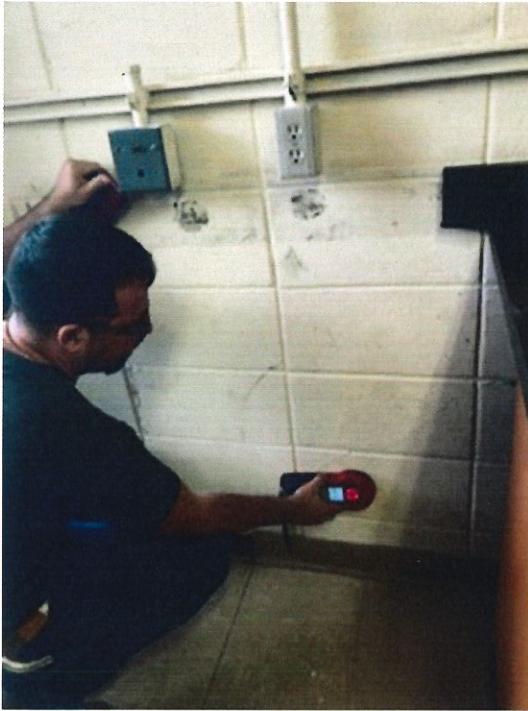
Verificación de refuerzo de paredes de bloque
