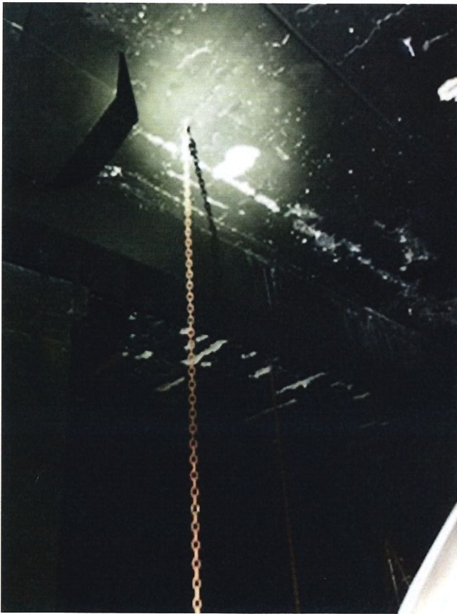
Desprendimiento de hormigón debido a corrosión y anclaje de elementos de soporte del domo
