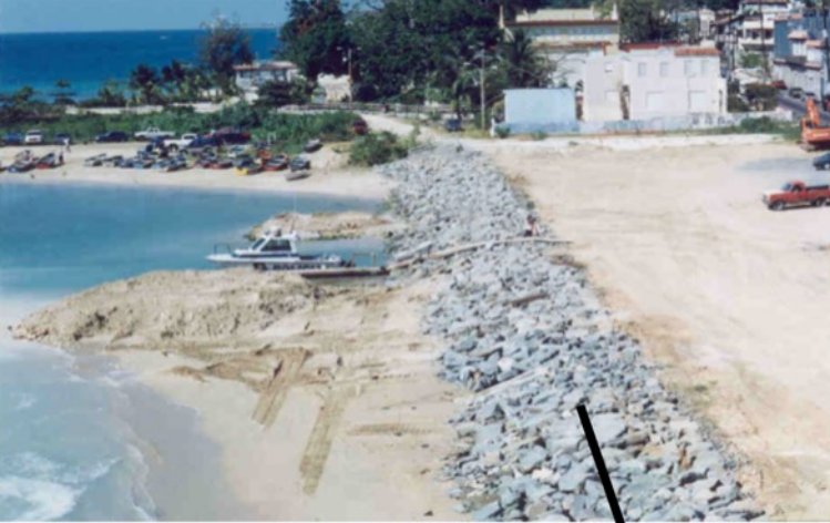
B. Muro de Rocas fuera del agua Rip Rap
