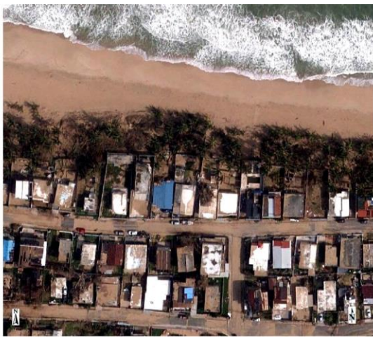
Imagen 42. Estructuras después del huracán
