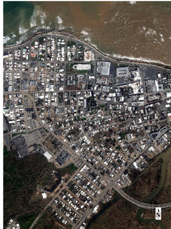
Imagen 26. Estructuras Arecibo 23/sept/ 2017
