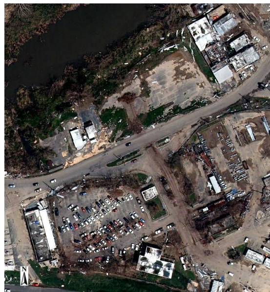
Imagen 36. Estructuras después del huracán
