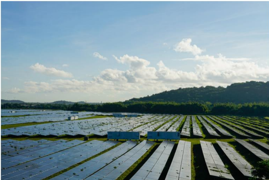
Figura 35. Vista lateral del proyecto Fonroche (GPJ, 2024)
