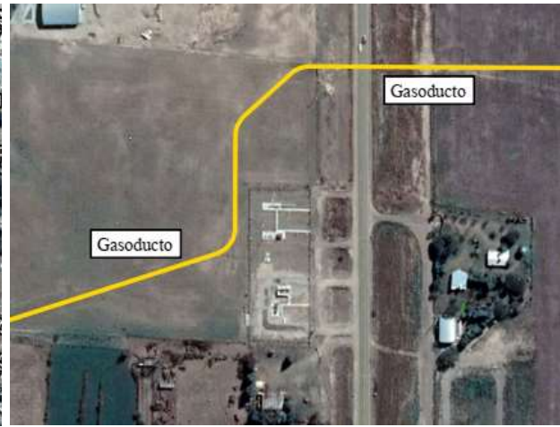
Figura 25: Traza rural de gasoducto 18" en Río Primero.
