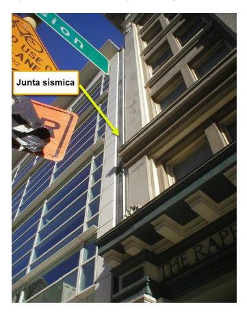
Diseñar y construir una junta sísmica es una tarea complicada y engorrosa. El ancho requerido aumenta de piso en piso y por simplicidad se construyen con la separación requerida para el piso más alto, pero esto tiene un costo asociado. Las juntas requieren cubiertas que deben ser resistentes a las inclemencias
