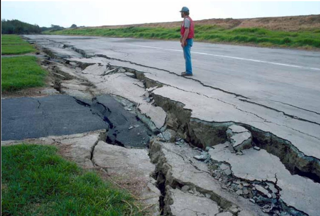
B) Corrimiento lateral (“Lateral spreading”) debido a licuación de suelo a causa del terremoto de Loma Prieta en 1989 (Foto S.D. Ellen, USGS).
