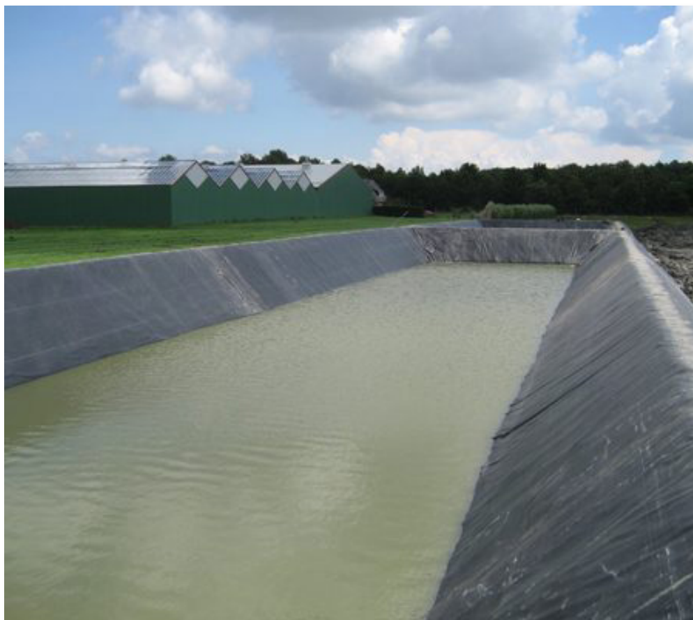
Foto 1. Charca de almacenamiento de agua de riego con protector de plástico. Tomado de Seal Eco, Värnamo. Suecia.
