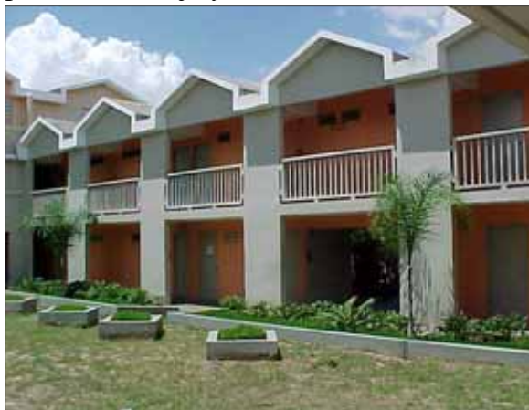
Patio Interior “Villas del Peregrino”
